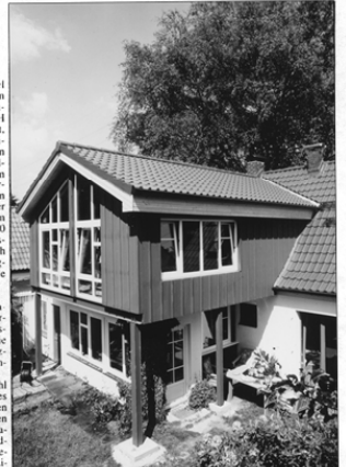
Diese Dachaufstockung aus Holz schafft innen mehr Platz für die Familie und nach außen ein harmonisches Gesamtbild.
