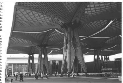
Das spektakuläre ExpoDach belegt: Holz erfüllt bravourös alle technischen Anforderungen, die heute an zukunftsfähiges Baumaterial gestellt werden - und das nicht nur bei Ingenieurbauten wie dem 16.000 qm großen Dach. Auch bei jedem Ein- und Zweifamilienhaus, das im handwerklichen Holzbau errichtet wird, gilt der Okobaustoff Nr. 1 längst als leistungsfähiges und zuverlässiges Material, das überdies ein Maximum an Gestaltungsfreiheit lässt. Foto: hagebau Soltau
